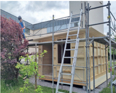
Gerätehaus Heerbrugg: Bau
